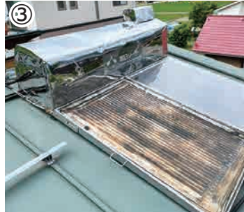
③朝日ソーラー撤去作業
