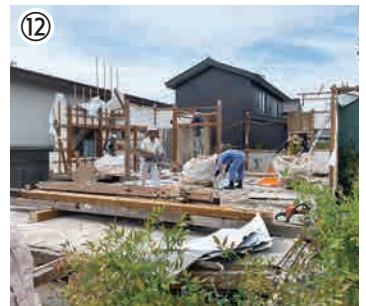
⑫住宅、作業所解体撤去作業
