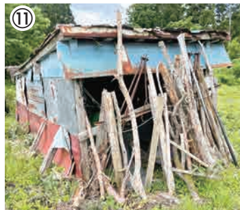
⑪小屋解体撤去作業
