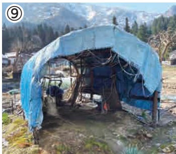
⑨簡易丸車庫撤去作業
