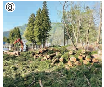
⑧敷地内森林伐採撤去作業
