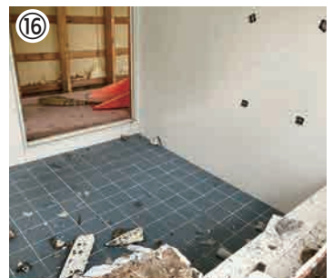
⑯浴槽改築撤去作業
