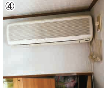
④エアコン撤去処理作業
