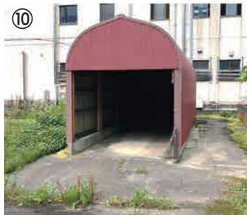
⑩丸車庫、基礎土間撤去作業
